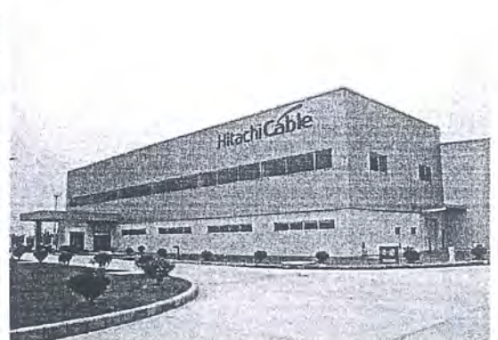
Nhà máy Hitachi Cable
